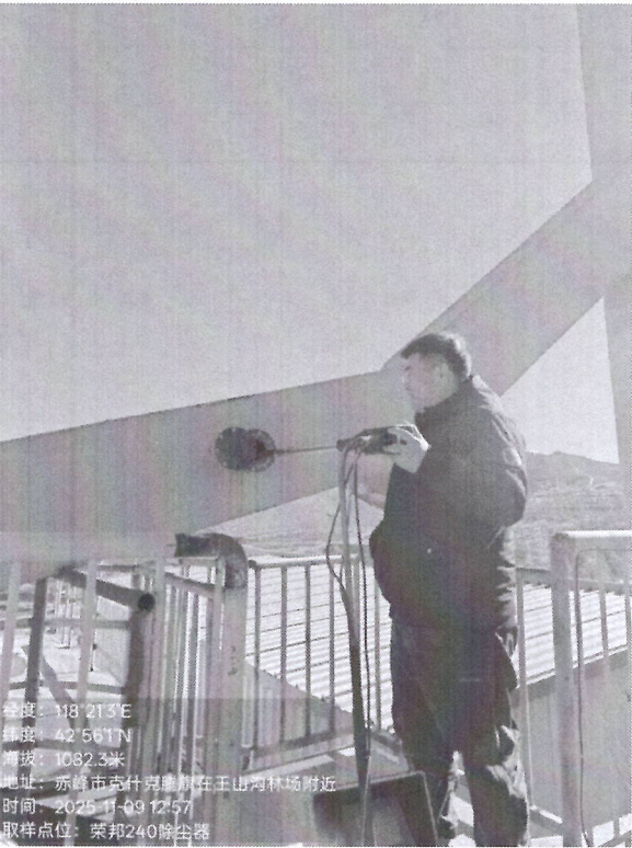
SDMC-240除尘器出口
