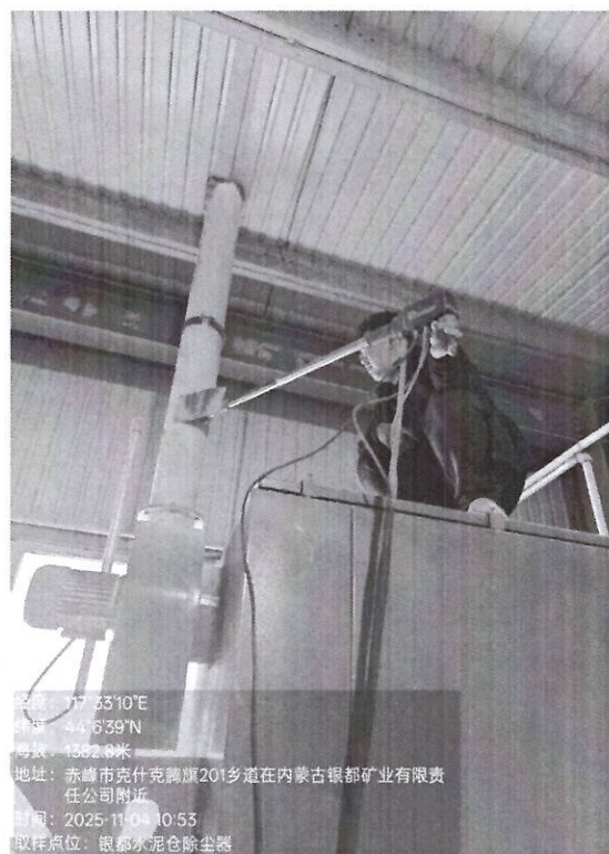
水泥仓除尘器排气筒监测口
